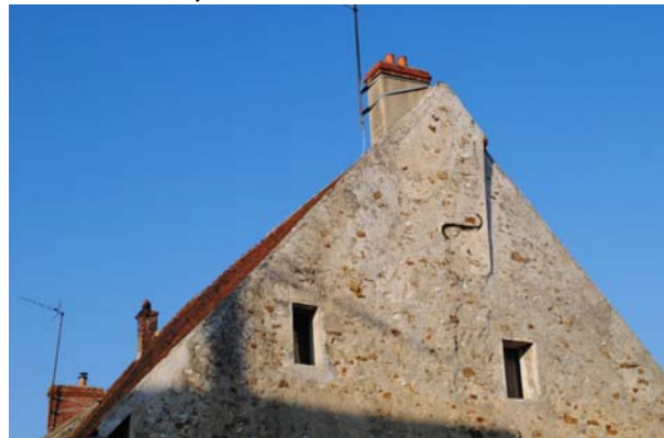
Ruellée fine, souche de cheminée
